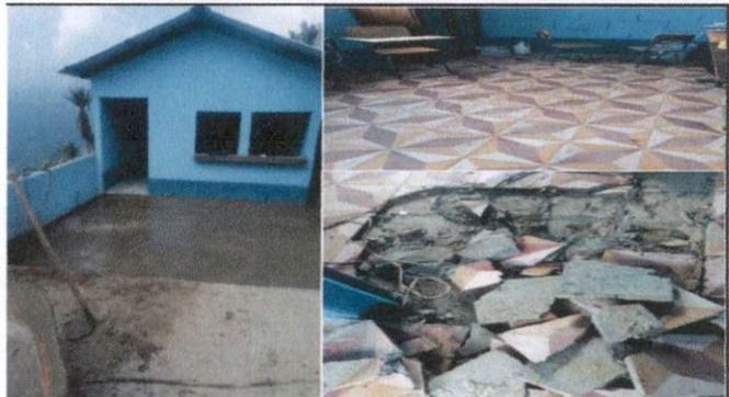
Foto 2: Sustitución de piso de cemento líquido Y Sustitución de piso de granito
